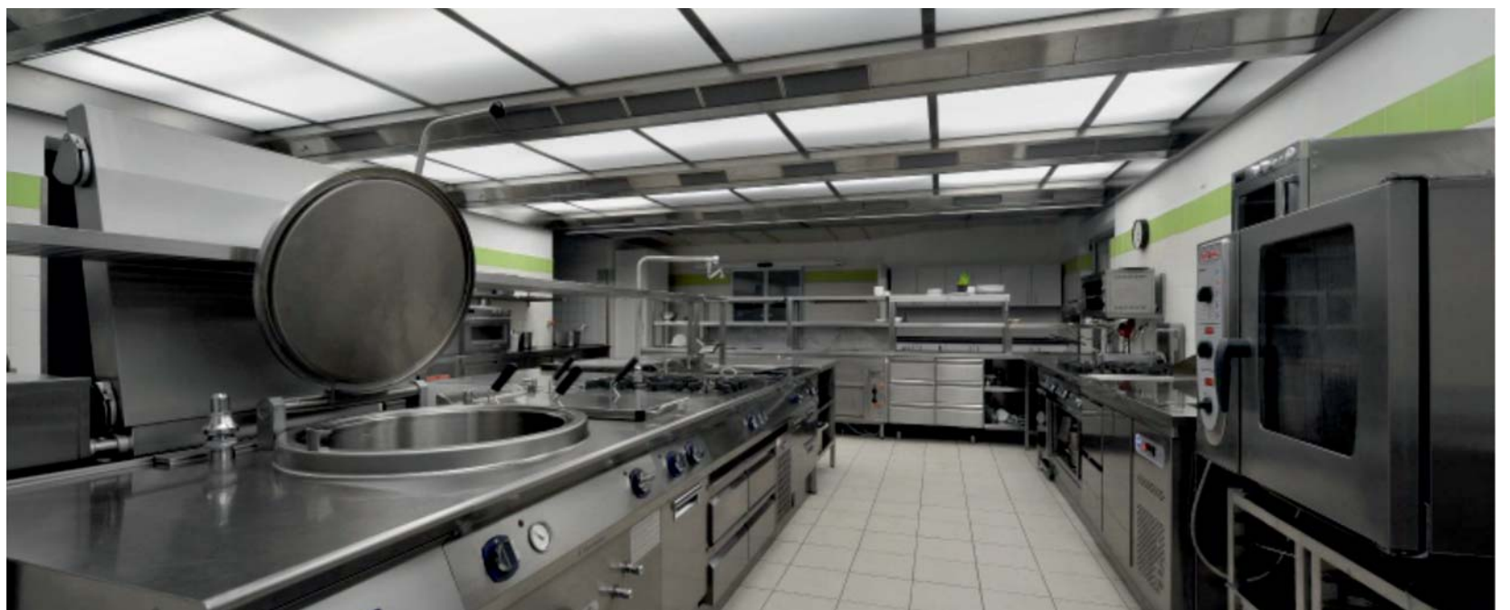
Dokončený odsávací strop.
