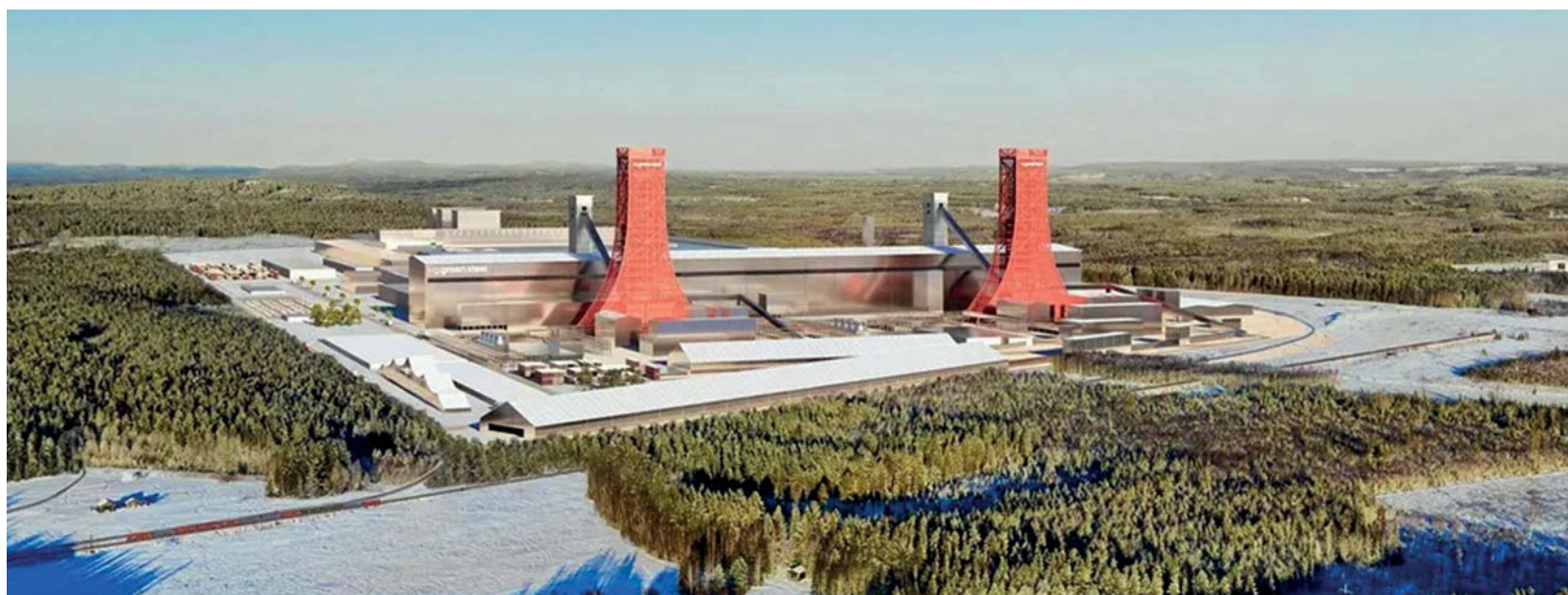
První velká továrna na zelenou ocel na světě společnosti H2 Green Steel získala financování ve výši téměř 6,5 miliardy eur. Jde o velký milník na cestě k urychlení dekarbonizace ocelářského průmyslu. Ocelárna H2 Green Steel vyrostle v Bodenu na severu Švédska. Objem emisí CO 2 má klesnout až o 95 procent oproti tradiční výrobě ve vysokých pecích vytápěných koksem. Stavba vlnkové lodí zelené ocelárny s integrovanou výrobou zeleného vodíku a zeleného železa je v plném proudu.
