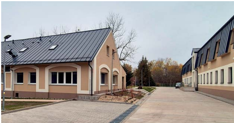
Zrekonštruované objekty zariadenia sociálnych služieb.
